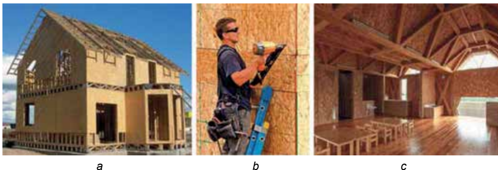
25. ábra. OSB lapok felhasználása: a – épületek falazásához; b – tetőfedéshez
