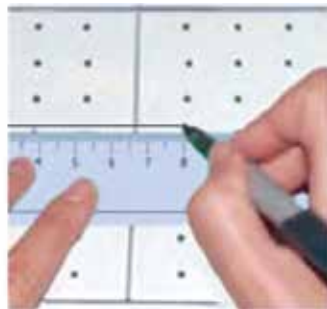
255. ábra. Rögzítő elemek helyének bejelölése
