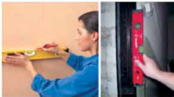
254. ábra. Felület bejelölése szintezővel: a – vízszinteség; b – függőlegesség
