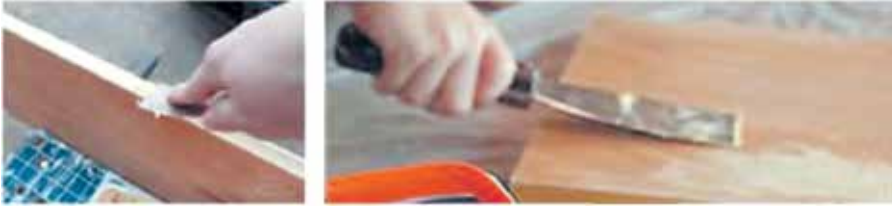
142. ábra. Glettelés folyamata
