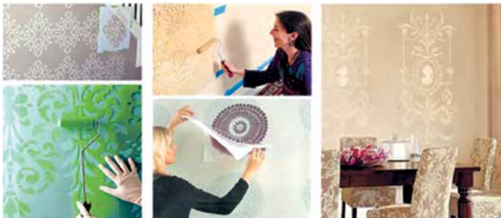
228. ábra. Minta készítése sablon (stencil) segítségével
