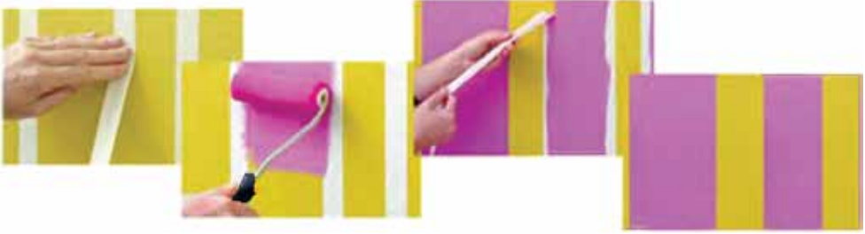
222. ábra. Falcsíkozási technológia
