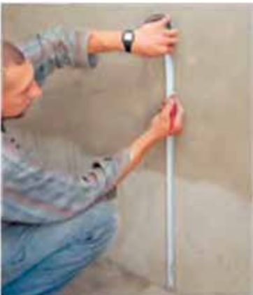
244. ábra. Rejtett elektromos vezetékek helyének bejelölése
