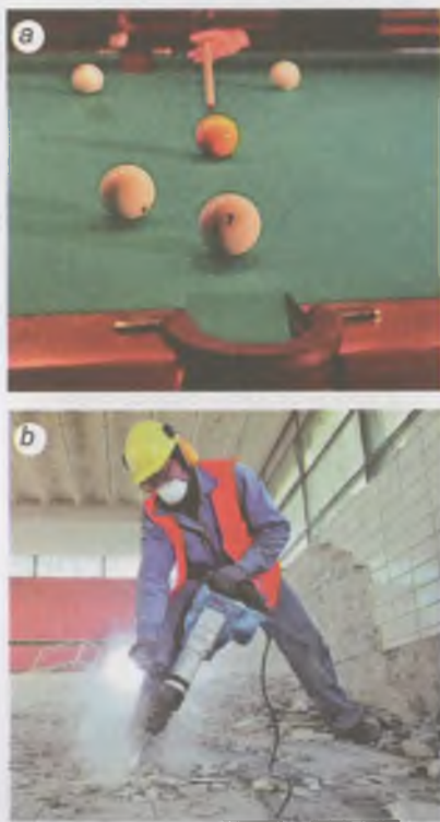
36.3. ábra. Biliárdgolyók mozgása ütközés után (a); légkalapács visz-szaütése (b) – mindegyik mozgás létrejötte az impulzusmegmaradás törvényének következménye
