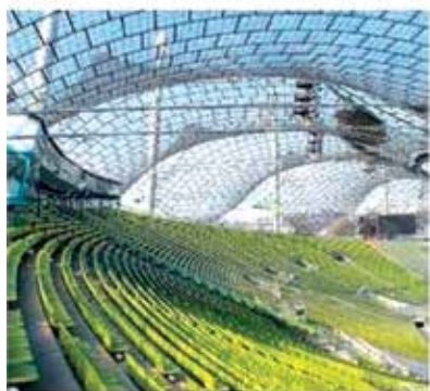
41. ábra. Acélhuzalból készült a müncheni olimpiai stadion félig áttetsző napfénytetője
