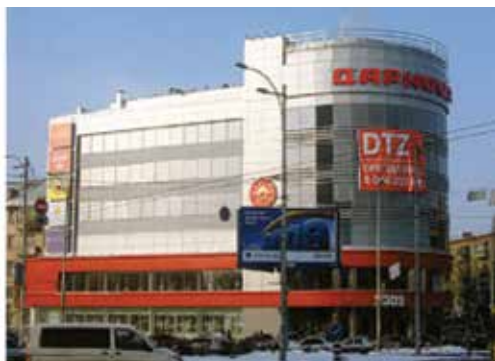
212. ábra. A kijevi Darnyica nagyáruház
